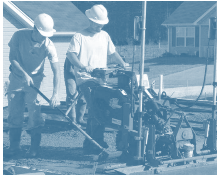
Somero® Mini Screed™ es idóneo para nivelar losas de hormigón en construcciones residenciales y de pequeños comercios.
